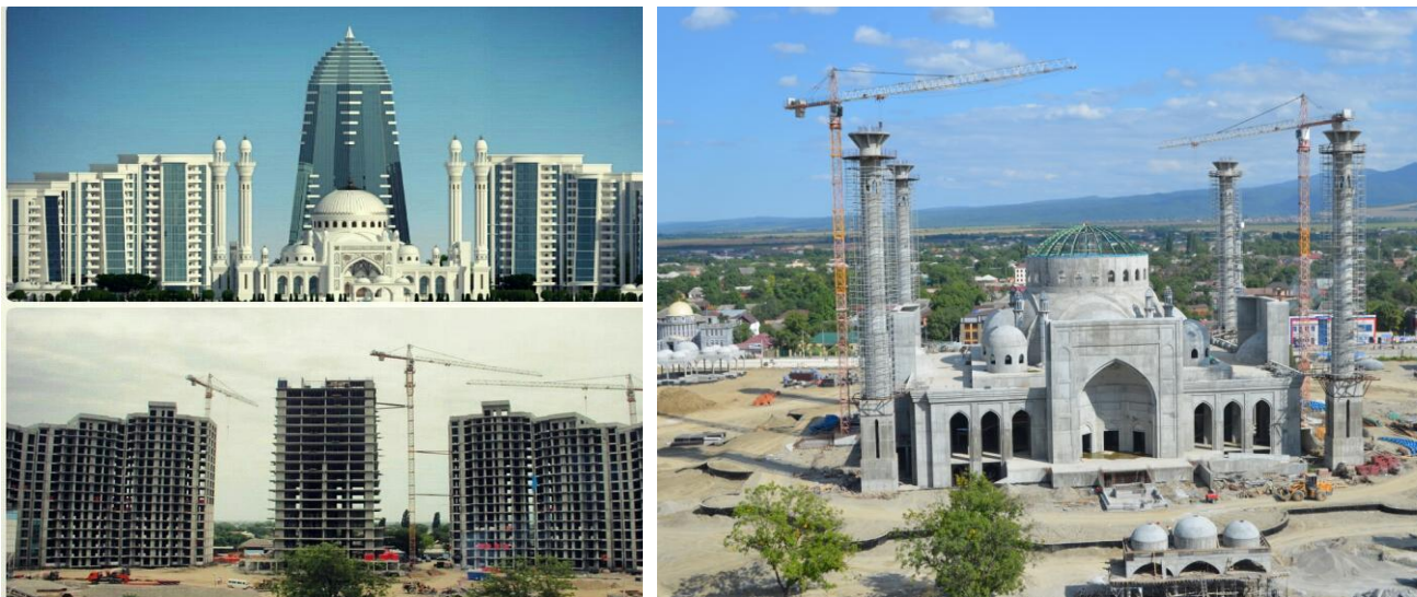
Рисунок 6 – фотография строительства комплекса высотных зданий «Шали-Сити» и мечети им. Р.А. Кадырова.
